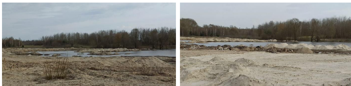
Рисунок 3 – Отсыпка насыпи для строительства микрорайона 59А (фото автора)
