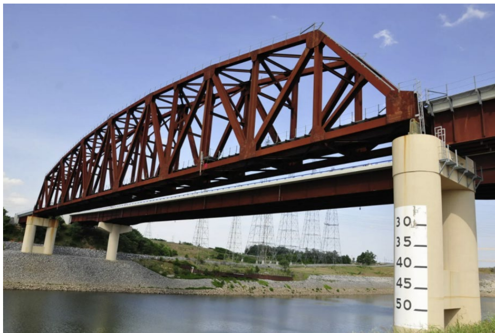
Рис. 1. Автодорожный мост из кортеновской стали
