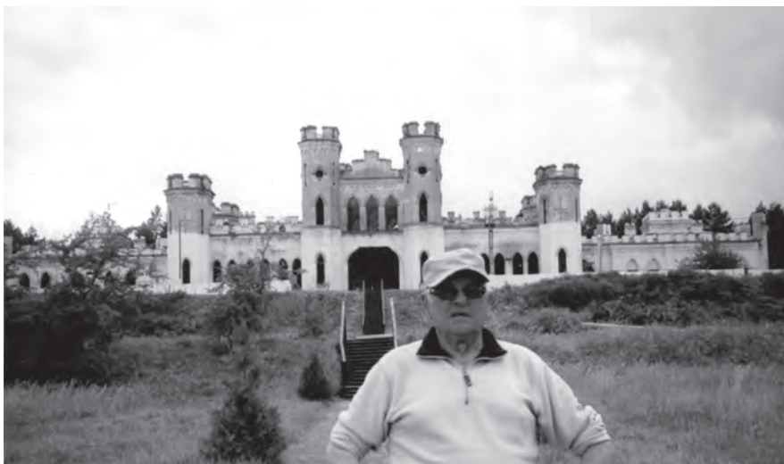
Widok ogólny pałacu Pusłowskich w odbudowie (2011 r.) Na pierwszym planie autor artykułu. Fot. Eugeniusz Iwaniec
