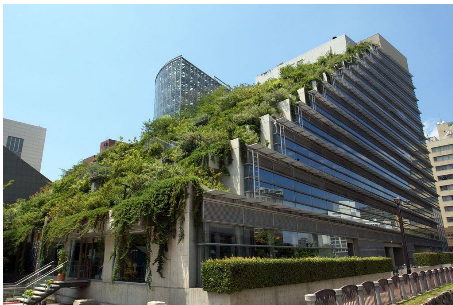
Рисунок 2 – Ярусные террасы на здании ACROS в городе Фукуока (Япония) [Электронный ресурс: http://zvt.abok.ru / Дата обращения: 01.03.2020]
